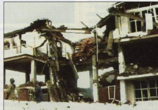
FABRIKA: Amerikanci su je srušili ne zato što su znali šta proizvodi već zato što nisu znali šta se u njoj radi
